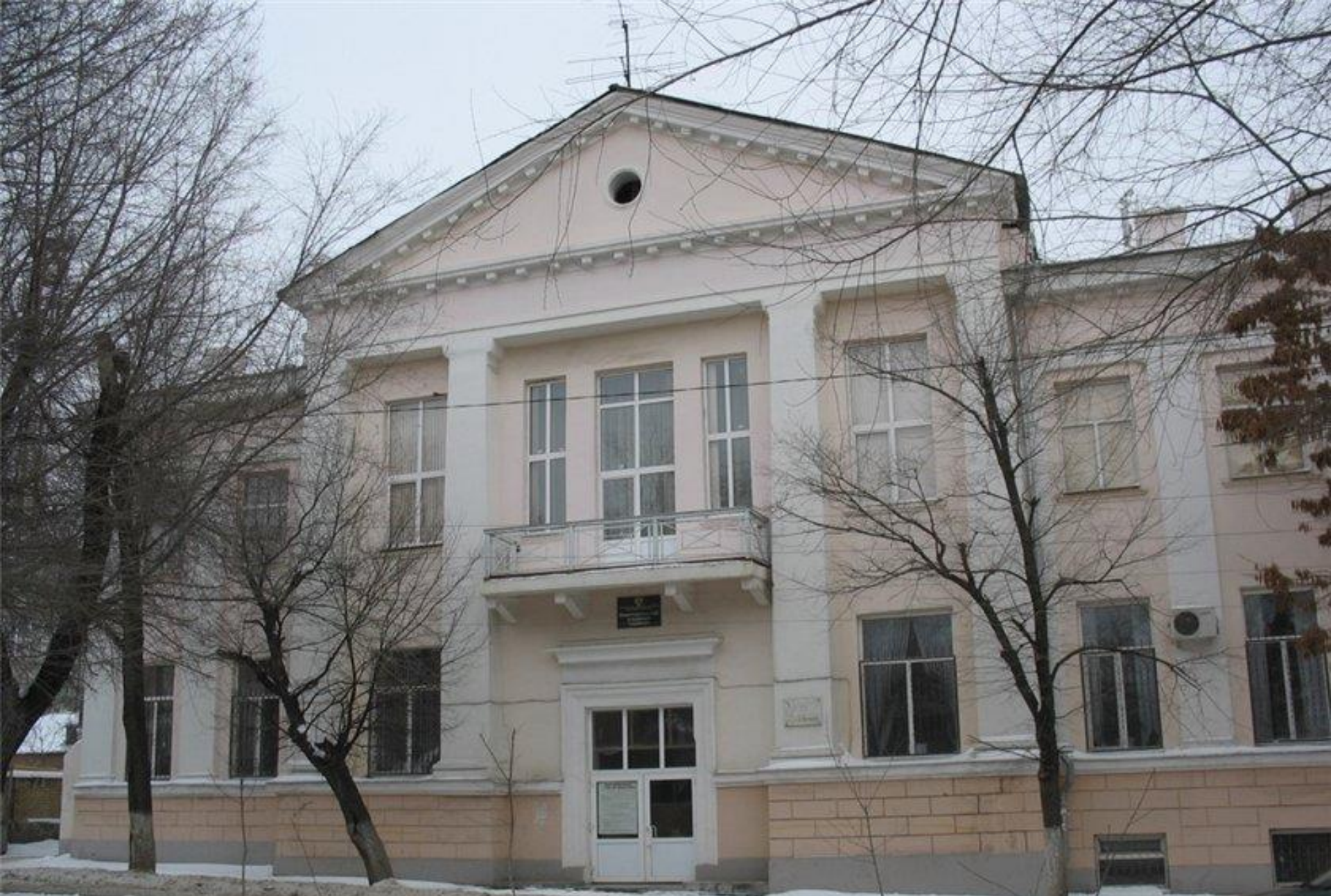
Здание Торговой школы, было построенное в стиле модерн, расположено на улице Пушкинской. Реконструкция 1955 года кардинально изменила облик здания, в котором ныне расположен аграрный
